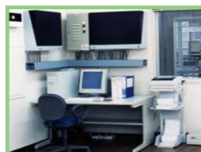
気象観測ステーションと室内環境センサーの情報に基づいた全自動総合環境制御設備
