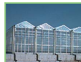
換気に優れた高い軒高のガラス温室
